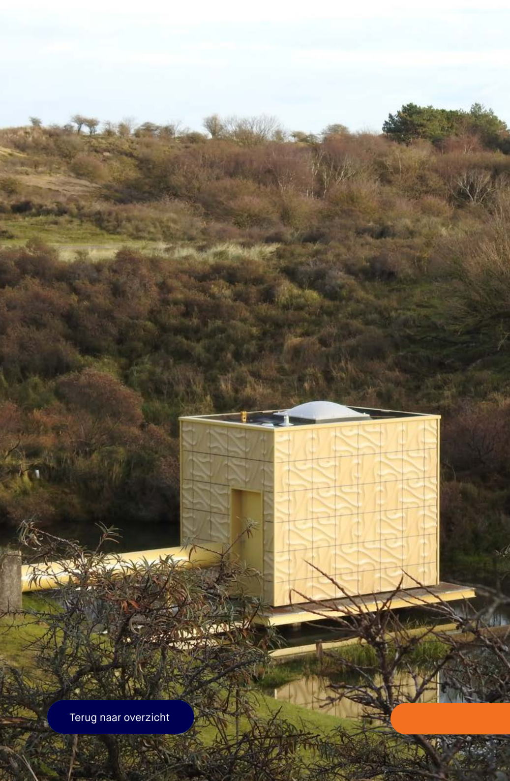
Drinkwaterpompstation met gevelpanelen van biocomposiet.
