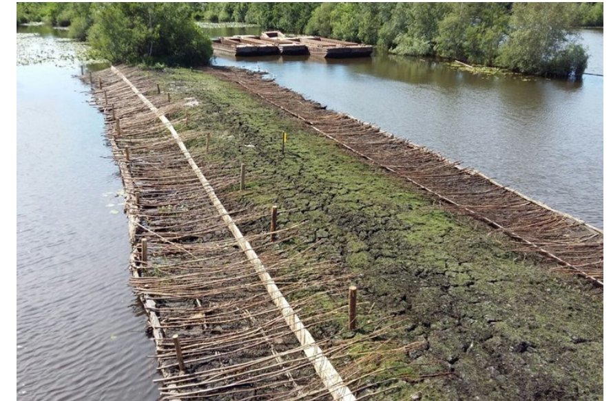
Met bagger aangelegde legakker
