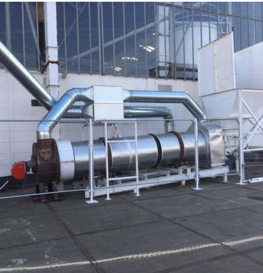
The Calcite Factory in aanbouw
