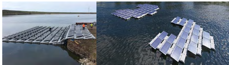
Aanleg drijvende PV-systeem
