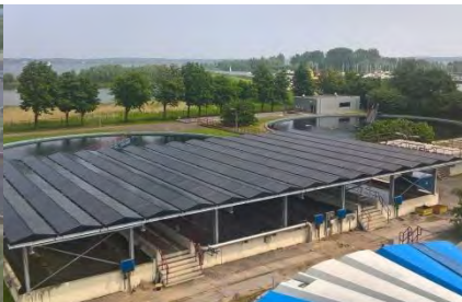
384 zonnepanelen boven een aeratietank op de rwzi Huizen
