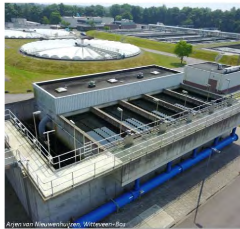
Het 1-STEP filter van bovenaf
