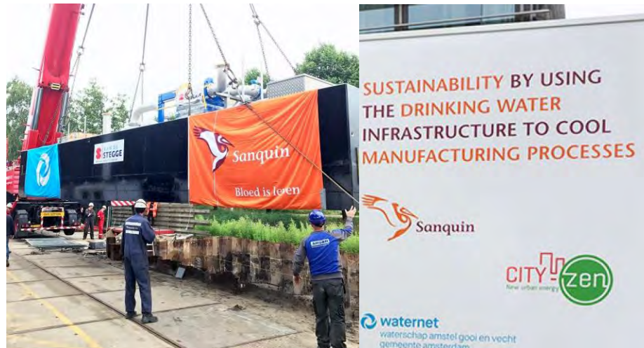
Installatie Sanquin Amsterdam
